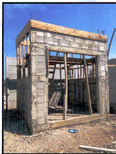
LEVANTADO COMPLETO DE MUROS EN GARITA
