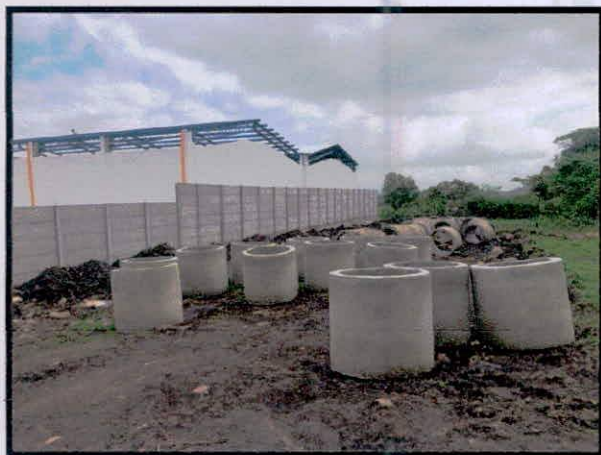
SUMINISTRO DE TUBOS DE CONCRETO Ø 36" MEDIA SECCION PARA AREA DE CUNETAS EXTERIOR
