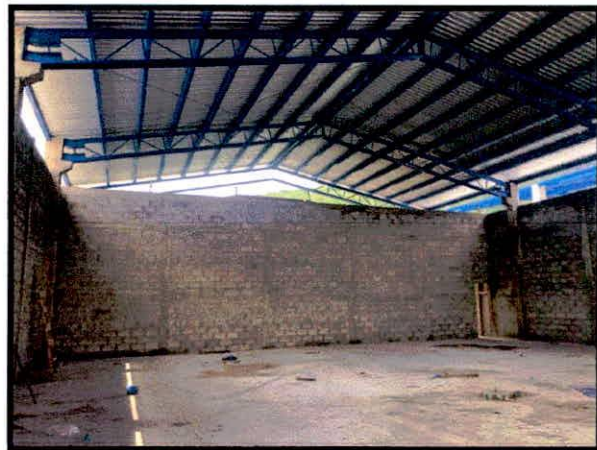
FINALIZACIÓN DE INSTALACION DE ESTRUCTURA METALICA PARA TECHO Y LAMINADO
