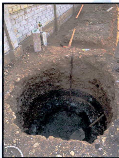
POZO DE ABSORCIÓN NO. 2 DRENAJE SANITARIO
