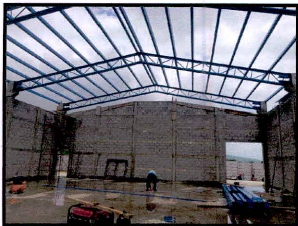
INSTALACION DE ESTRUCTURA DE METAL DE TECHO PARA MODULOS NO.1 Y NO. 2
