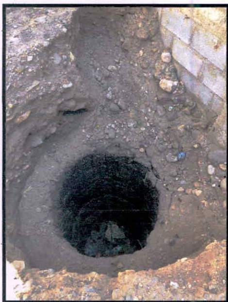
POZO DE ABSORCIÓN NO.1 AGUAS PLUVIALES
