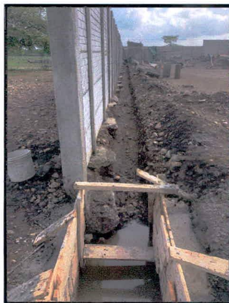
ZANJEJO PARA LA INSTALACION DE CUNETAS INTERIOR
