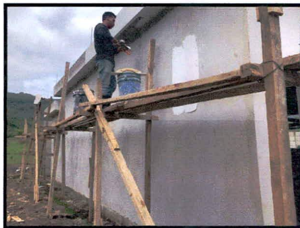
REPELLO Y ALISADO DE MURO POSTERIOR DE SALON DE CAPACITACIONES
